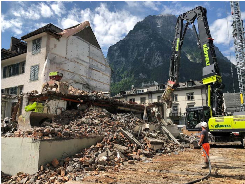
Das alte Gebäude der GRB Glarner Regionalbank in Glarus musste weichen.
